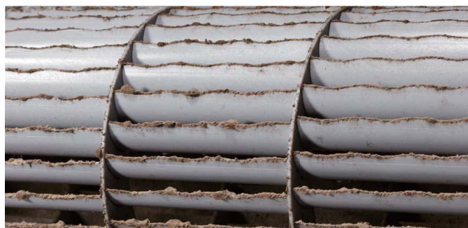
ホコリの溜まったファンの羽根先端部 (約2年間使用したエアコンの一例。使用状態や環境により異なります。)
